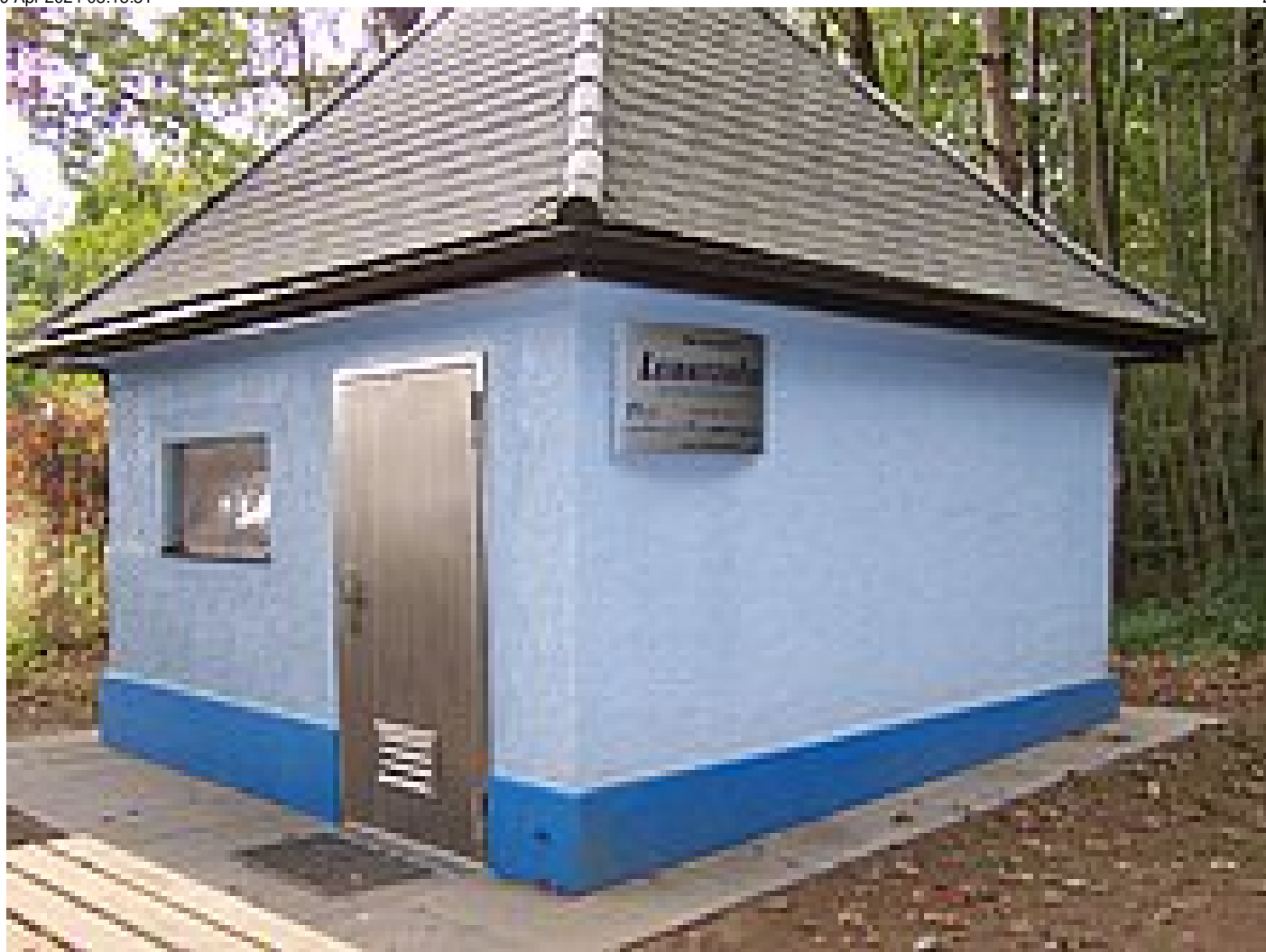
Leibnitzerfeld Wasserversorgung GmbH - pumping station Kaindorf 1
